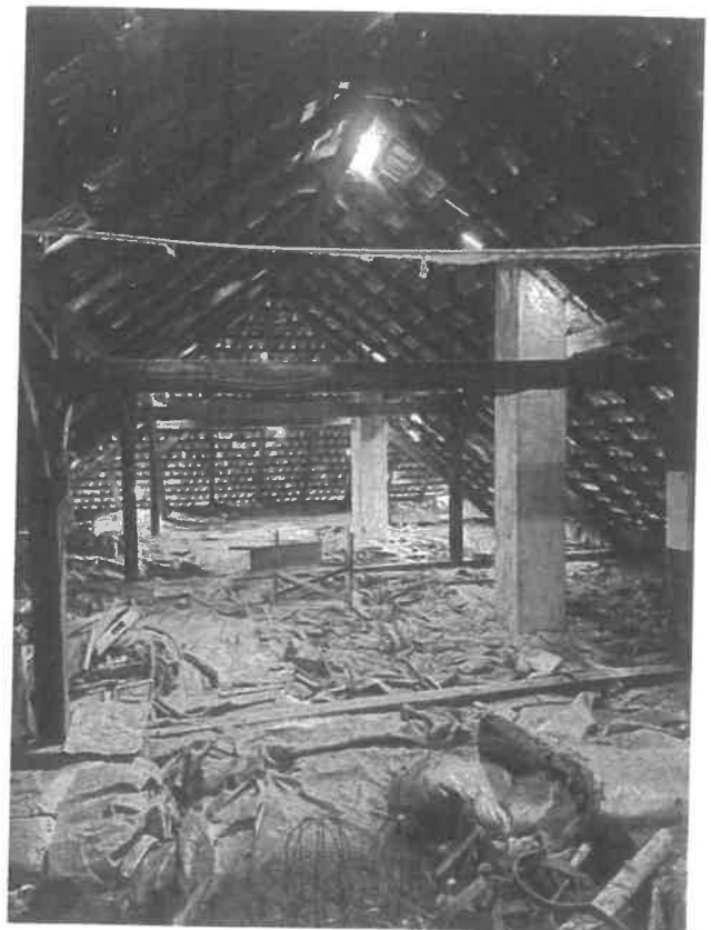
Zagyvarékas iskola padlás
