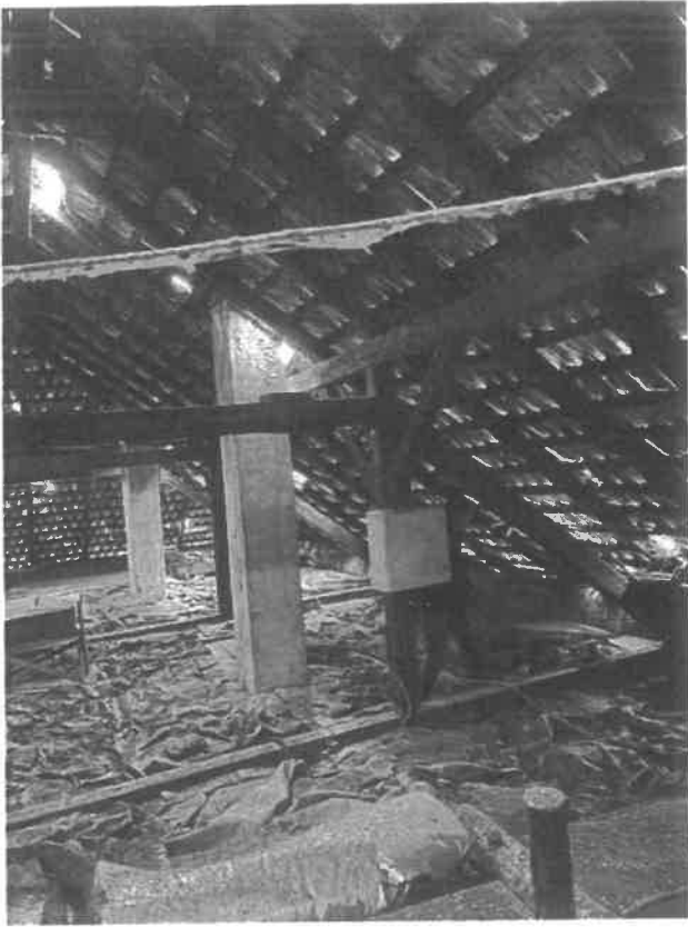
Zagyvarékas iskola padlás
