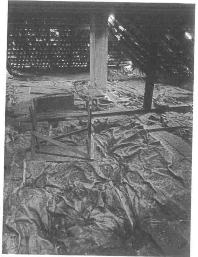
Zagyvarékas iskola padlás
