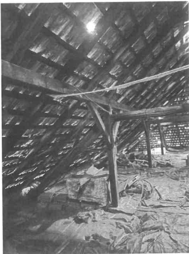
Zagyvarékas iskola padlás
