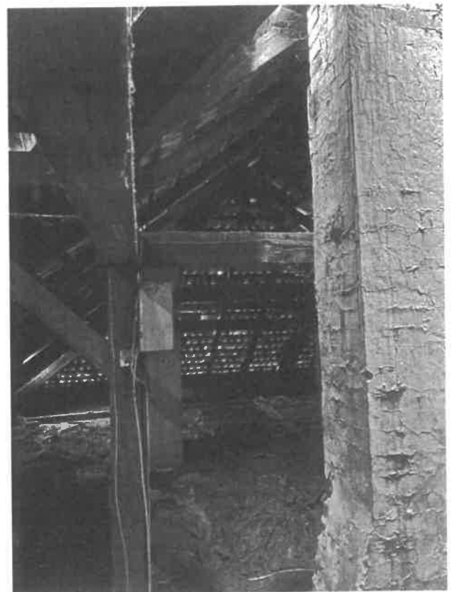
Zagyvarékas iskola padlás
