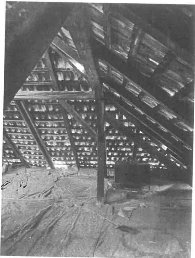
Zagyvarékas iskola padlás
